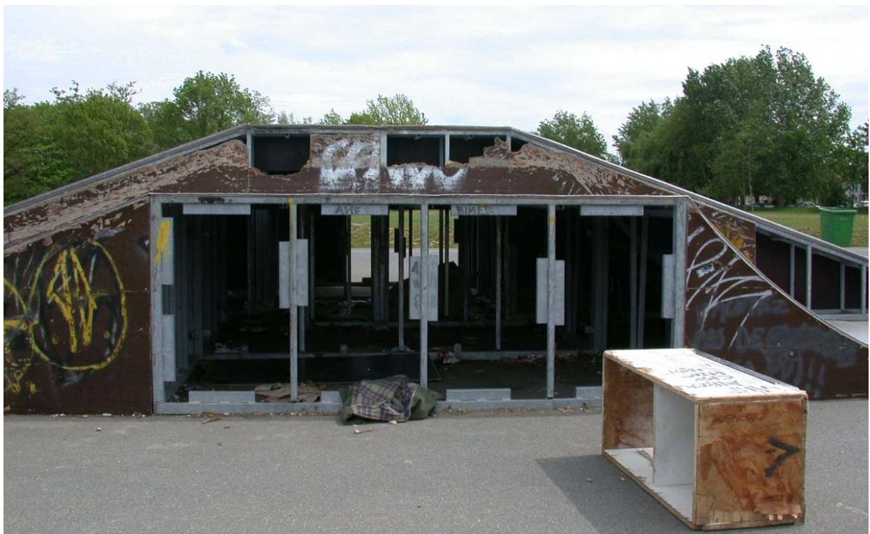
Exemple du skatepark de la base de loisir « Le port aux cerises » dans le 91, après 2 ans d'utilisation. Aucun contrat d'entretien n'avait été prévu. Il est indispensable quand on utilise des matériaux comme le bois.
